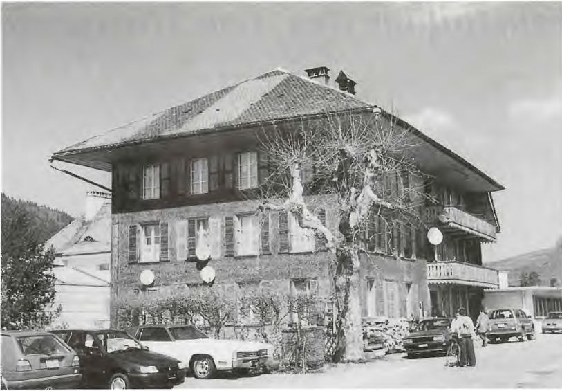
Zwei Zeitalter begegnen sich in diesem Bild: Parabolantennen am 155-jährigen Haus, davor die letzte Platane (gefällt im August 2001) des alten Friedhofs. Aufnahme vom April 1997.
