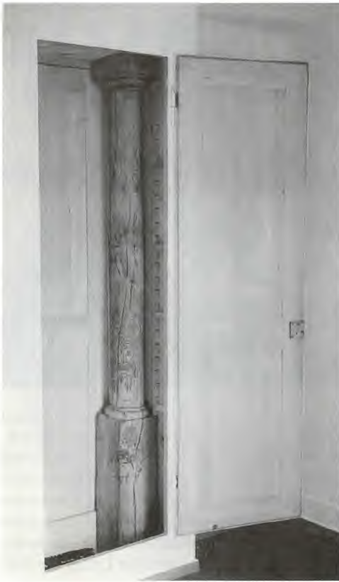
Versteckt in Wohnzimmerschränken standen bis zuletzt die tragenden Holzsäulen der alten Schulstuben.
